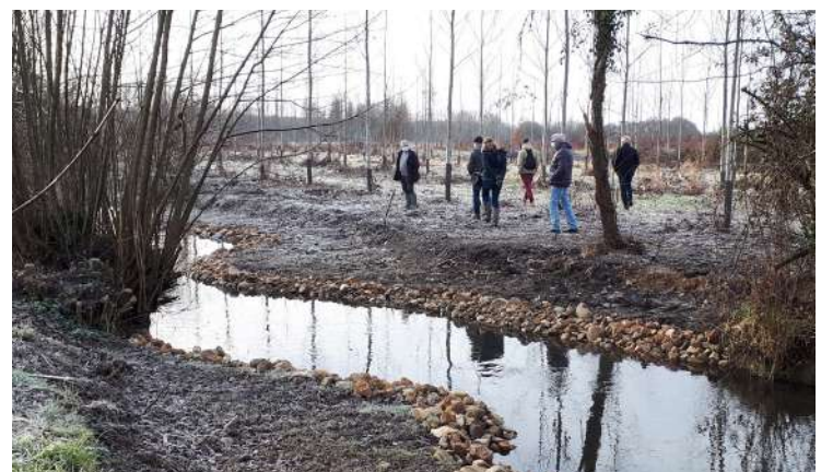
Visite de travaux sur la Veude, affluent de la Vienne, à Jaulnay (37)
