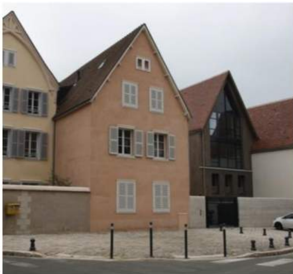
Chartres - 28 Dans l'opération de restructuration Le clos Notre-Dame (150 logts/ha), située à proximité directe de la cathédrale Notre-Dame de Chartres, l'architecture contemporaine de l'habitat reprend la volumétrie et le gabarit des constructions patrimoniales du centre-ville.
